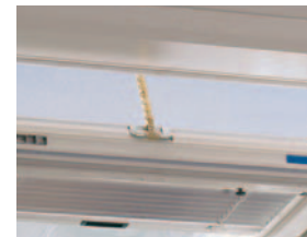
Verdeckt liegender Motorantrieb MA 25 N VO 24 V, max. Öffnungsweite 25 cm.
